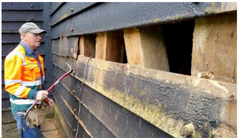
NY DRAKT PÅ GAMAL KYRKJE: Dagfinn Revheim tjærebreier kyrkja, og skiftar samstundes ut nokre av borda i kledningen.
